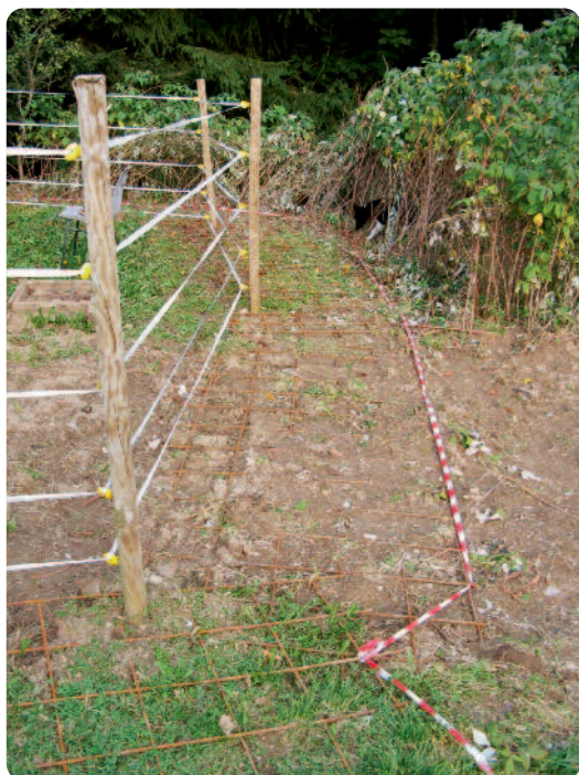
Foto n. 12 - Reti elettrosaldate antiscavo sperimentate alla base delle recinzioni elettriche (E. Bonapace, Archivio Servizio Foreste e fauna PAT)
