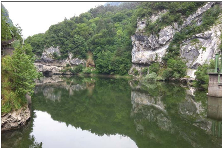
L'invaso di Ponte Pià sul fiume Sarca
